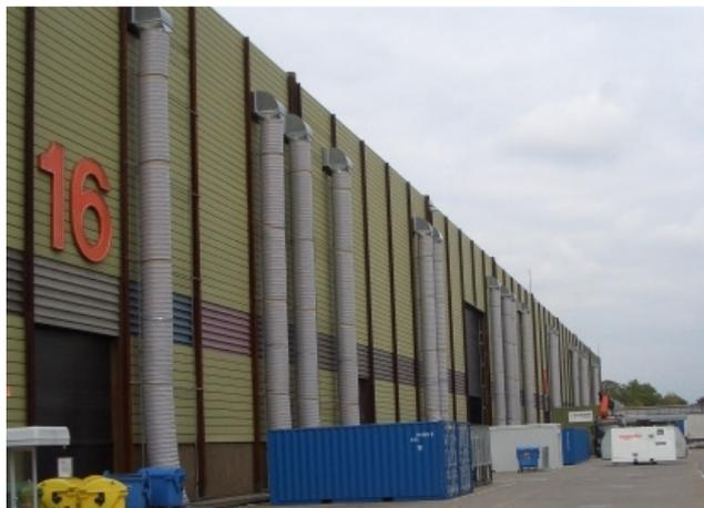
Flexibler Spiralschlauch aus PVC-beschichtetem Polyestergewebe mit aussen aufgeschweißter Spirale aus Federstahldraht, mit schwarzem PVC-Profil. Der Schlauchmantel ist längsverschweißt, d.h. der Strömungskanal ist innen glatt
